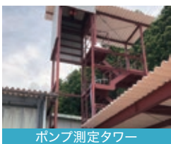
ポンプ測定タワー
