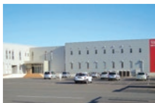
福山(広島)物流倉庫
