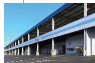
清水(静岡)物流倉庫
